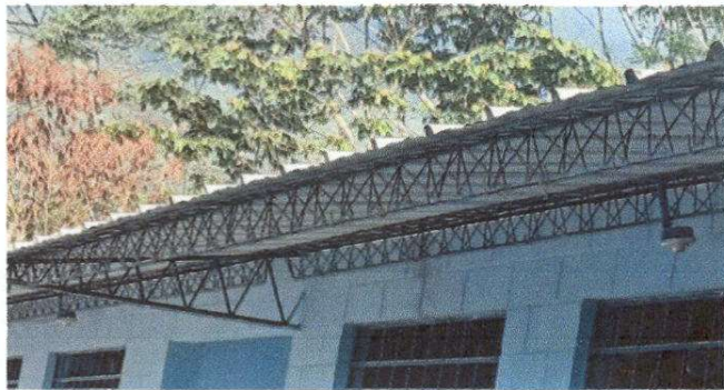
Foto 7: Sustitucion de lamparas tipo LED
