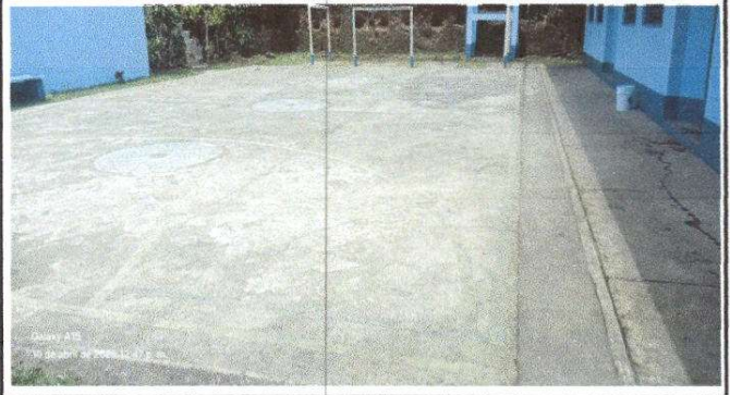
Foto 2: Reparación de piso de torta de concreto
